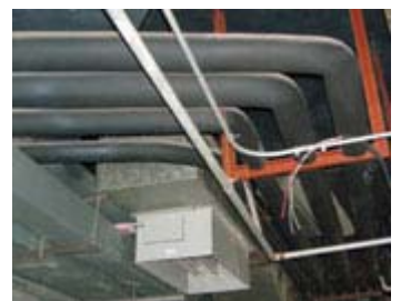
Los materiales de aislamiento de Armacell protegen las tuberías y los conductos contra la condensación y las pérdidas de energía
